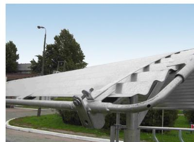
Telaio di protezione intorno al tetto in tubo di acciaio Ø 25 mm
